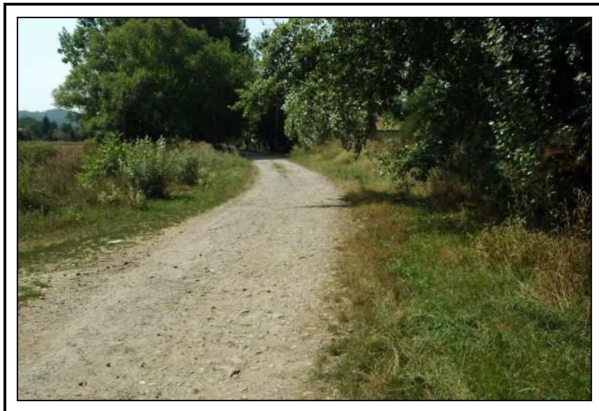
fotografia č. 4.4.1.: Poľnohospodárska cesta na začiatku projektového úseku (U11) s nevýrazným pruhom stromov a kríkov, a burinovým rastlinstvom na násype
